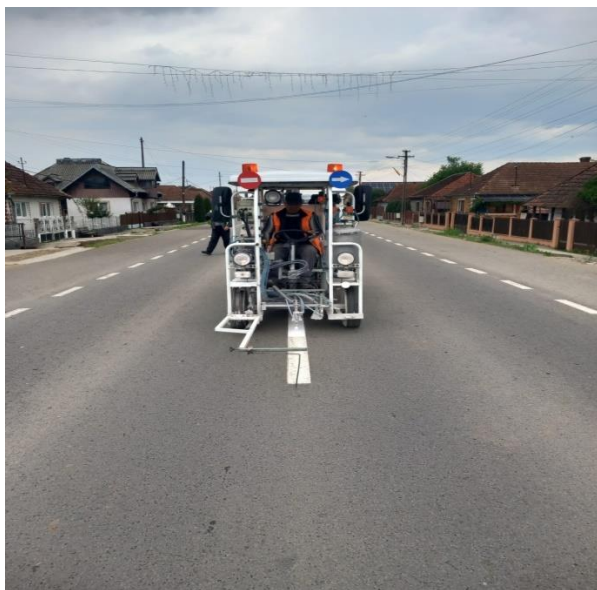
Imagini din teren de la lucrări de marcaj rutier:
